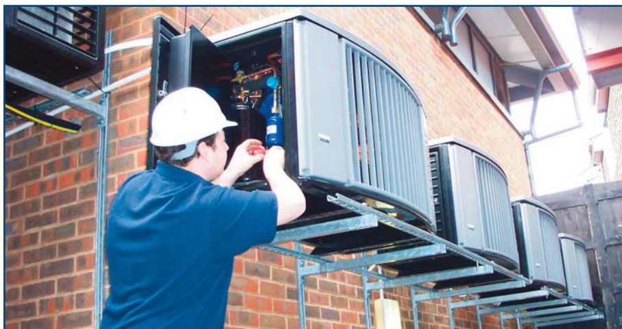
Installation of Copeland EazyCool™ outdoor condensing units | Installation des groupes de condensation "plein air" Copeland EazyCool™ | Installation : Copeland EazyCool™ Verflüssigungssätze zur Außenaufstellung
